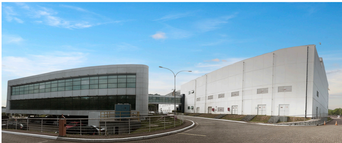
Prédios CEITEC - Acervo CEITEC
